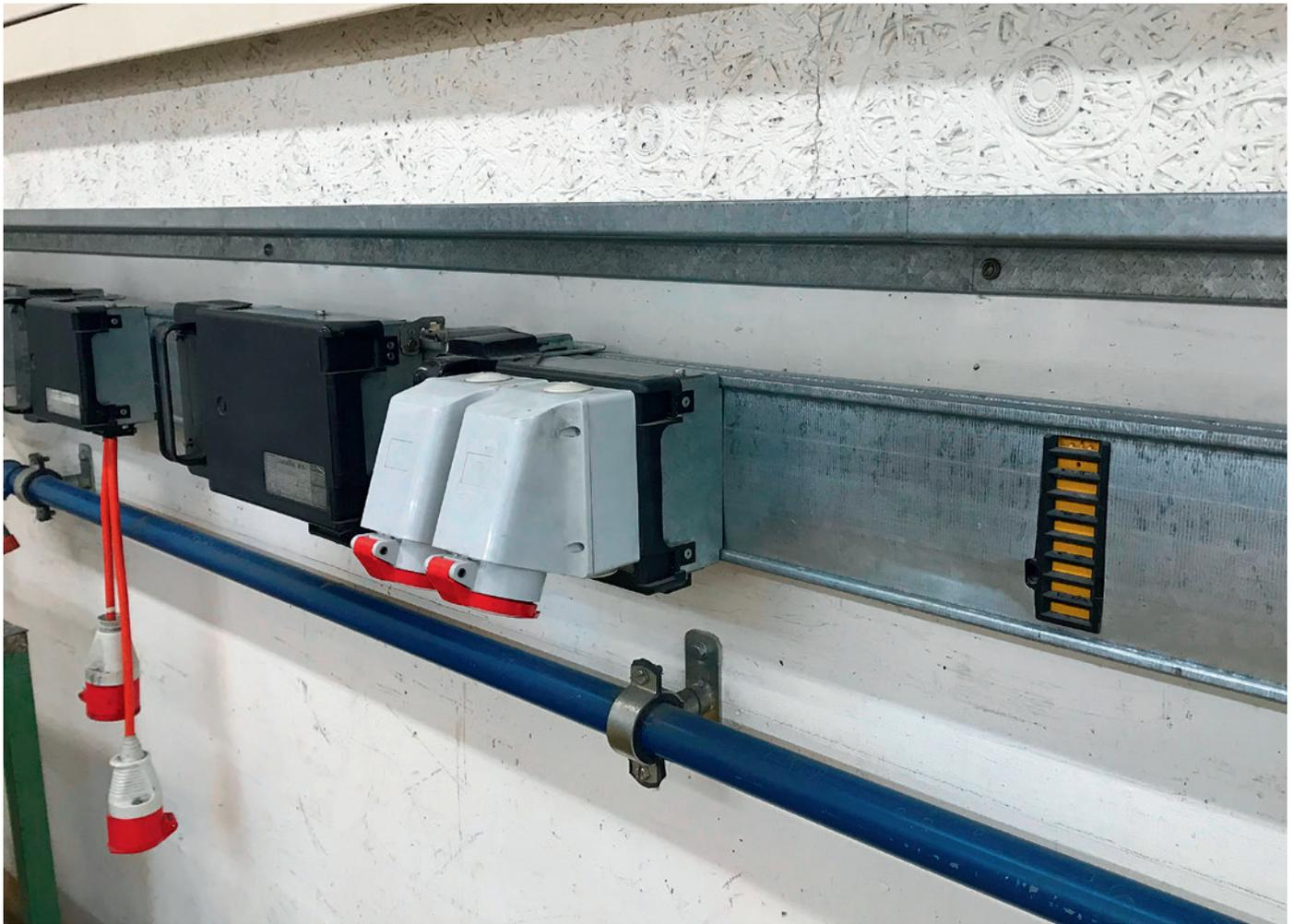
«plug and produce» – das flexible Stecksystem für Elektroanschlüsse ermöglicht eine sofortige Betriebsaufnahme.
