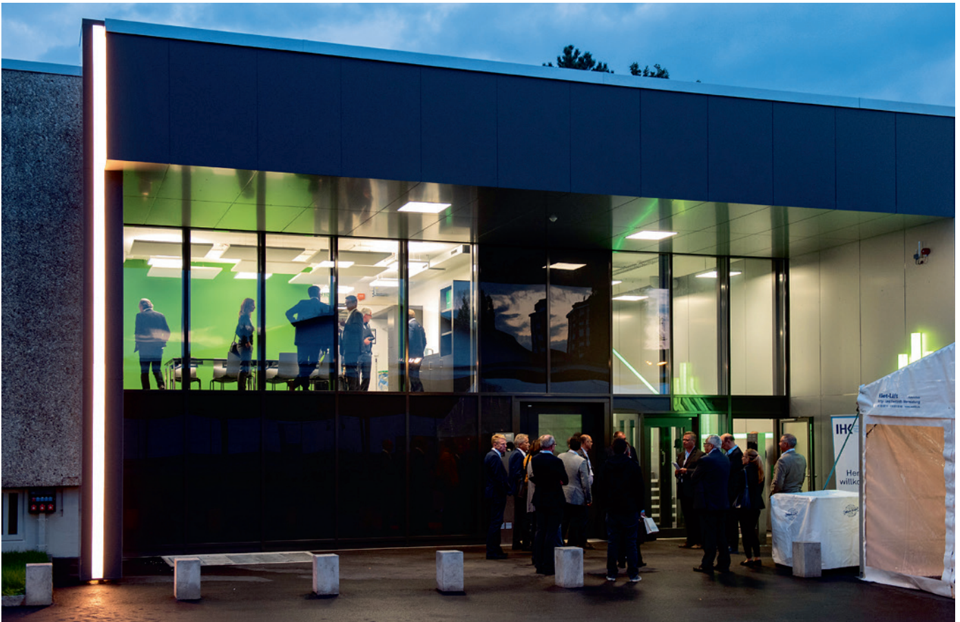
Informationsanlass zum Datenschutz im EKT Datacenter: Technische Einrichtungen verhindern einen unkontrollierten Zutritt.
